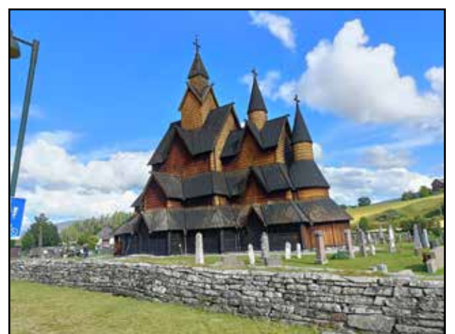
Heddalin sauvakirkko piirukirkko, rakennettu 1200-luvun puolivälissä. Rakennettu pystysuuntaisista lankuista, vaakasuuntaiset hirret, sekä pystysuuntaiset tukevat tolpat. Hieno nähtävyys E134
