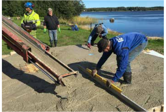
Pastori Arto Koivukoskelta hommat hoituu. Savusaunan pohjanteko käynnissä.
